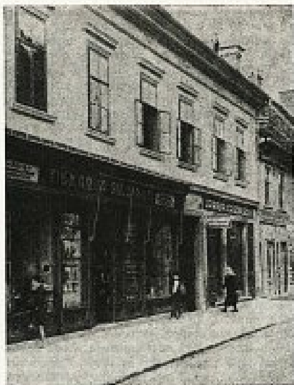
Pročelje Tiskarne sv. Cirila na Koroški cesti 5 v Mariboru. V prvem nadstropju je od 1908 do 1922 delovala osrednja knjižnica mariborske SKSZ. (Posnetek iz časa okrog l. 1930.)
