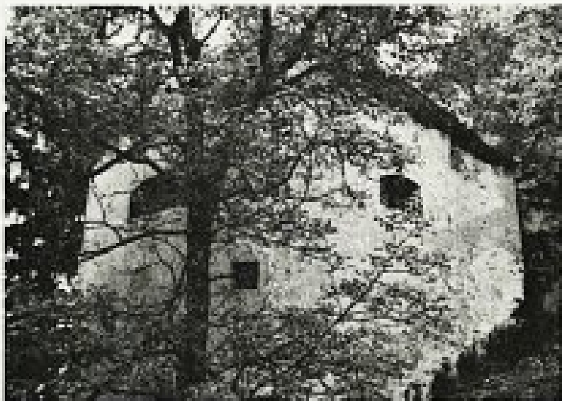
Severni okrogli stolp (Zaporni stolp)
