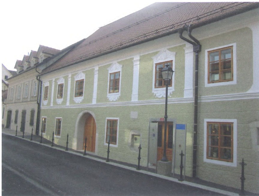
Leta 2006 odkrita prava Valvasorjeva hiša v Krškem je bila leta 2013 temeljito obnovljena (foto B. Golec, marec 2014).
