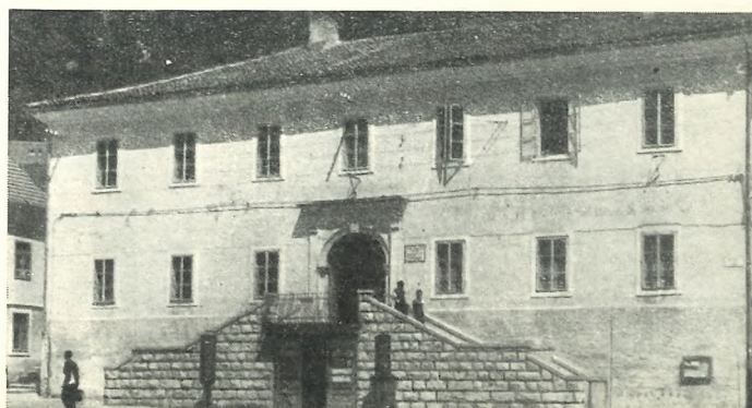
Sl. 1. Stavba Notranjskega muzeja v Postojni
