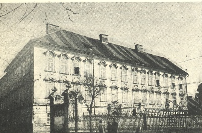
Sl. 1. Gruberjeva palača — zahodna fasada
