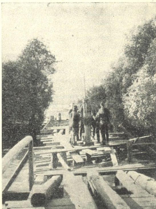
Gradnja mostu čez Krko (julij 1919)
