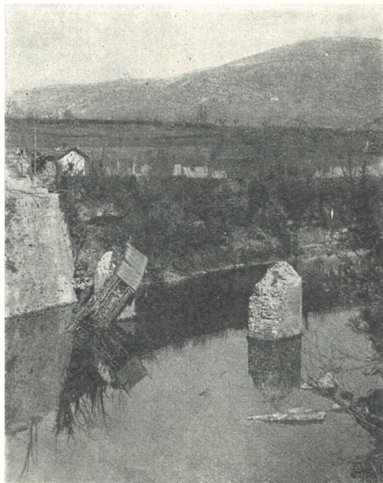
Porušeni most čez Sočo pri Pevmi
