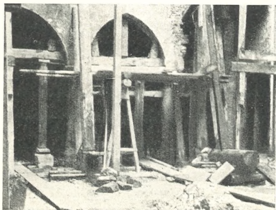
Mestna hiša v Ljubljani — obnova dvorišča srednje stavbe (1951); loki in arkadah rotovškega trakta pod grajskim pobočjem. Zanimiv je gotski lok
