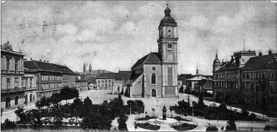
Nemška »trdnjava« ob Dravi (mariborski Stolni in Franc Jožefov trg (današnji Slomškov trg) z mestno stolnico)
