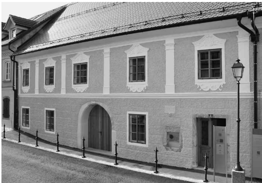
SLIKOVNA PRILOGA 1: Prava Valvasorjeva hiša v Krškem (Mencingerjeva hiša) po končani temeljiti prenovi leta 2013 (foto: Nina Sotelšek, oktober 2013)
