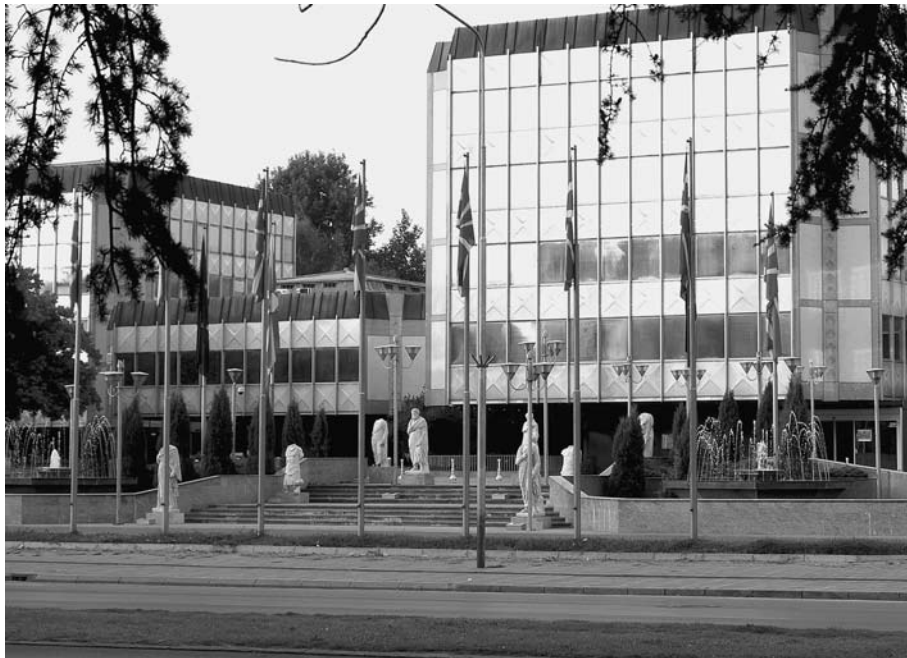
Slika 1: Antički originali ispred zgrade makedonske vlade.
