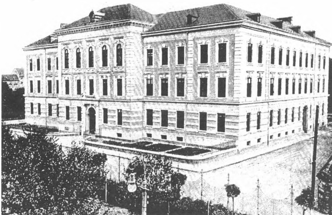
Zgradba Klasične gimnazije v Ljubljani nekdanj (ob otvoritvi 5. oktobra 1899) ...
