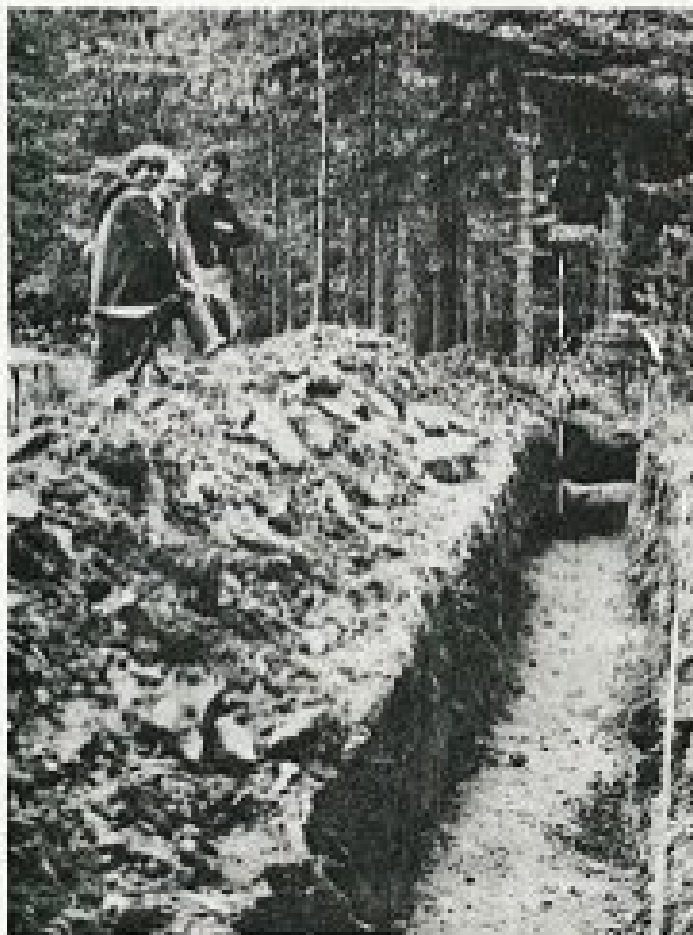
Sl. 9. Mislinska Dobrava — presek trdne in velkopotezno trasirane rimske ceste, ki je povezovala Caelo—Colatio—Virunum
