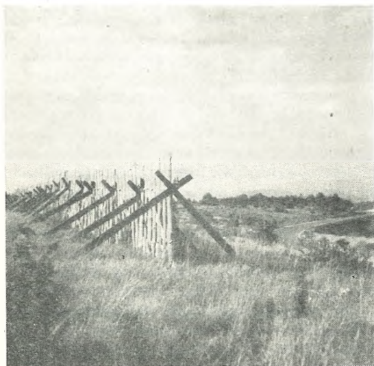
Varovalni plotovi na Krasu proti snežnim zametom po burji, 1963 (Fototeka Tehniškega muzeja Slovenije)
