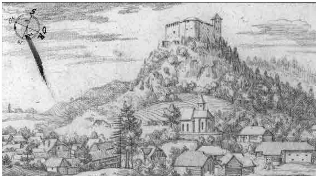
Naselbina Bela Peč z napol razkritim gradom z južne strani na risbi iz okoli leta 1678 v Valvasorjevi skicni knjigi za Topografijo Kranjske (Valvasor, Topografija Kranjske 1678–1679 . Skicna knjiga, str. 327).
