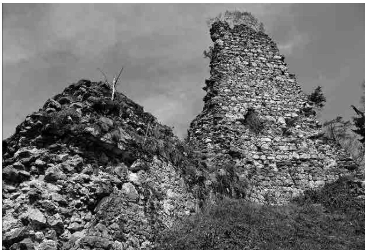
Visoka jugovzhodna stena vzhodnega klinastega zaključka grajskega jedra, območje vzhodnega medzidja in nižja vzhodna stena južnega prizidka grajskega jedra (foto: Igor Sapač, 2016).
