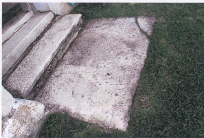
Kamnite plošče pri vhodu v cerkev. Foto: A. Gulič. 2006
