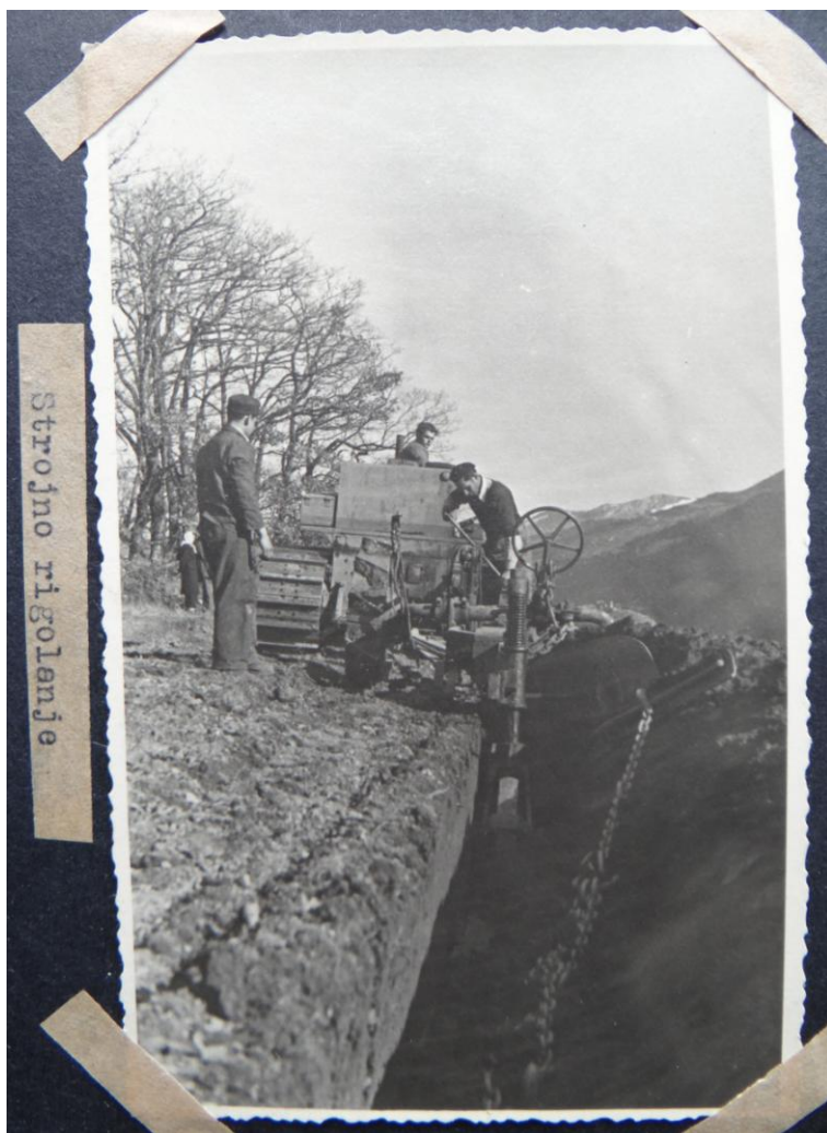
Slika 3: Prvo strojno rigolanje na Vipavskem, izvedeno na posestvu Kmetijske šole v Ložah. 32
