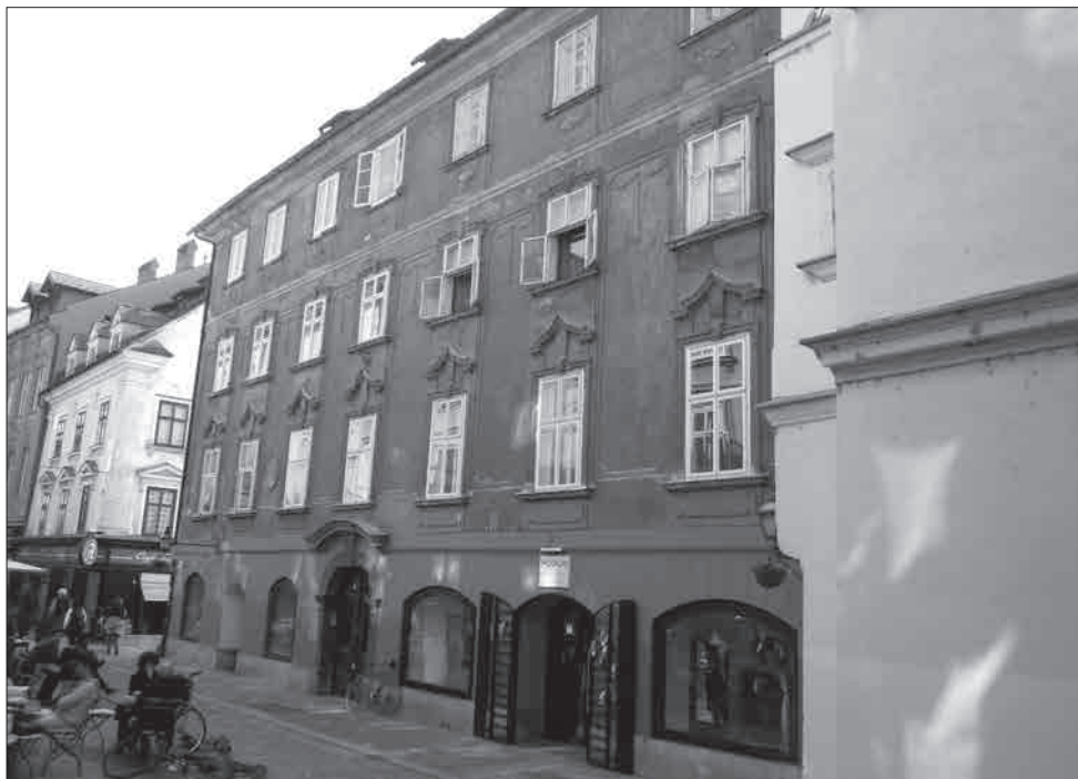
Hiša nekdanje mestne tehtnice in kruharne na Starem trgu (foto: B. Golec, april 2013).
