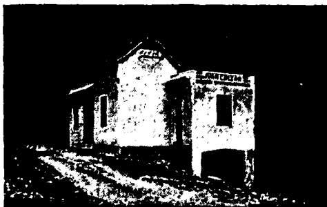
Elektrarna v Cerkljah, zgradil domačin Ivan Činžar l. 1925.
