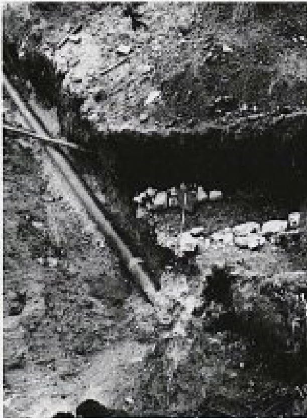
Kungota pri Ptuj, 8. 9. 1989. Križanje treh vodovodov: rimskega, krajevnega in novega povezovalnega vodovoda, Dobrovce - Kungota - Skorba. Foto: Ivan Tušek.
