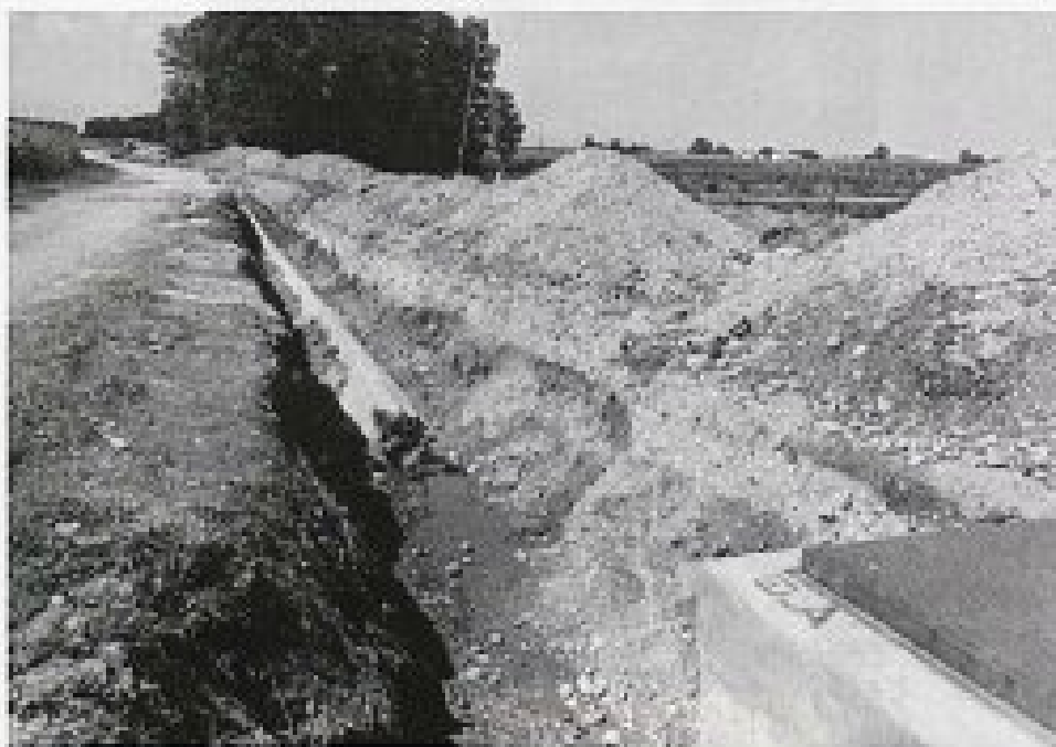
Skorba, 1989. Izkop za novi povezovalni vodovod, kjer se v profilu lepo vidijo ostaline prvega rimskega vodovoda. Foto: Ivan Tušek.
