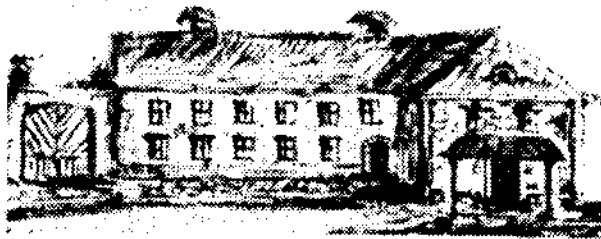
Pogled na stanovanjsko poslopje meščanskega špitala (Zbornik splošne bolnišnice v Mariboru, Maribor 1959, str. 34)
